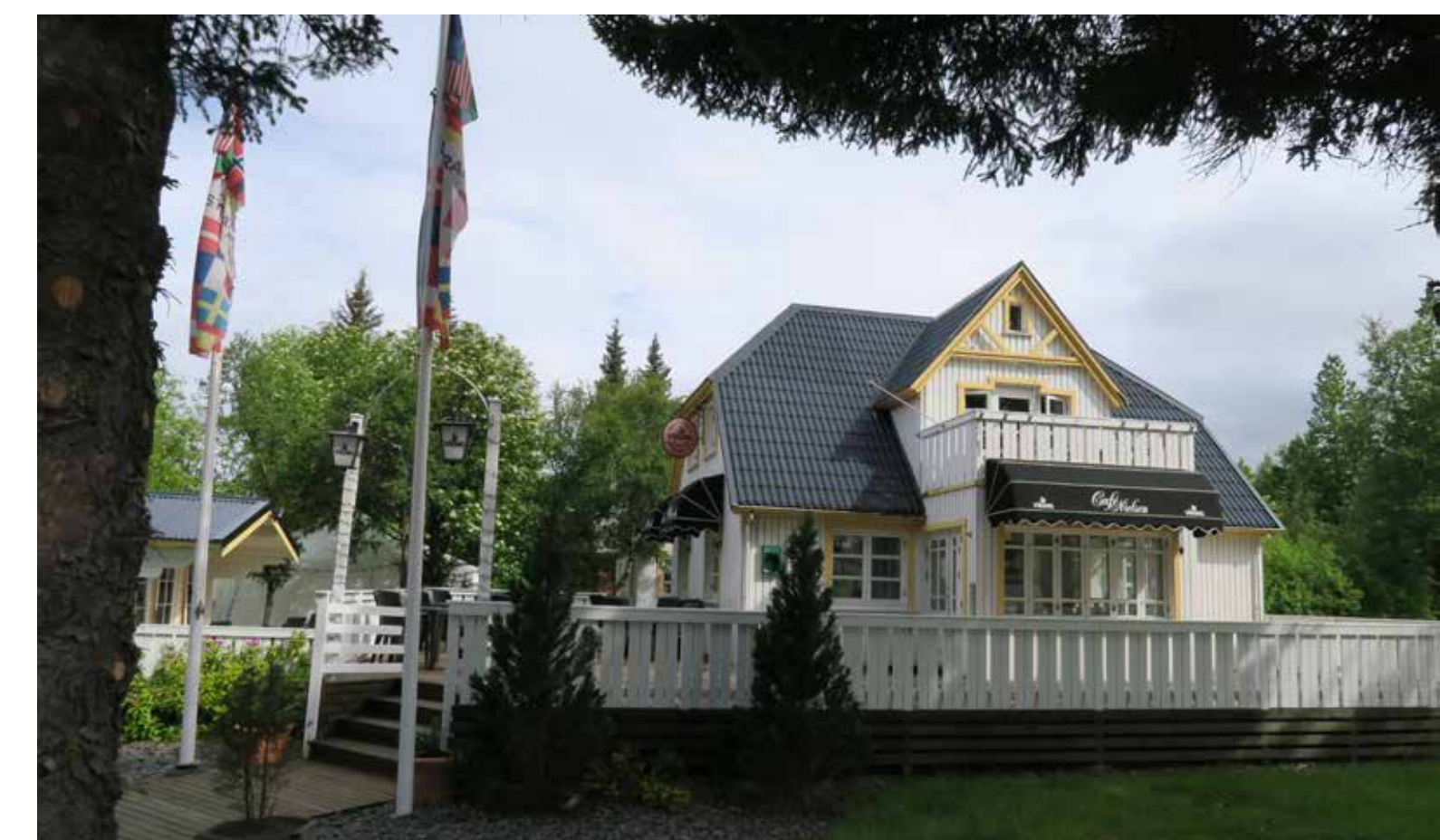
Nielsenshús, árið 2017. Útveggir húss nú klæddir, strompur farinn og ýmsu útliti breytt öðru og þakplötur eru ekki upprunalegar, en meginlínur í ytra útliti hússins hafa þó haldist. Ljós. Unnur B. Karlsdóttir.
