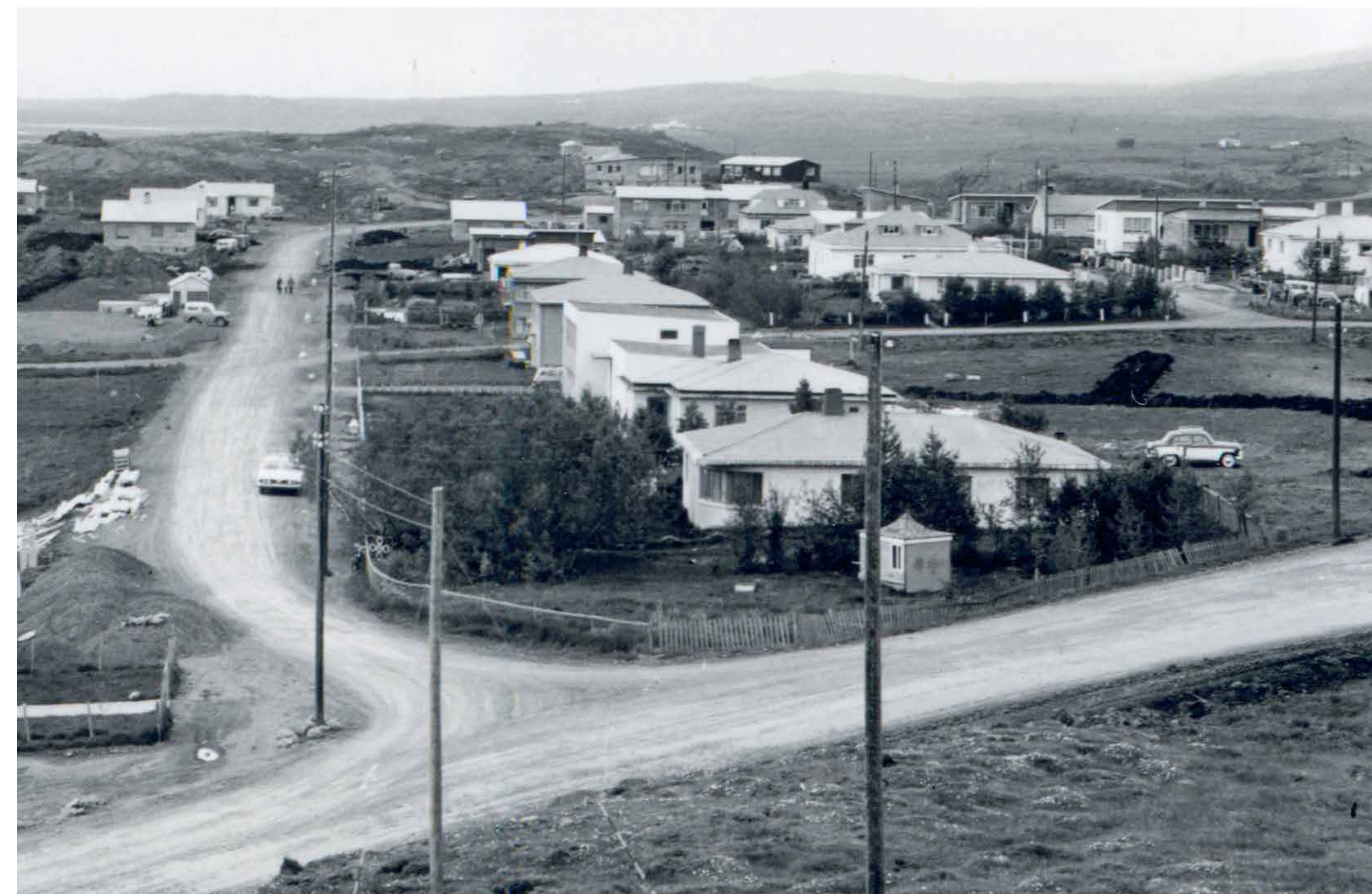
Horft yfir hverfið út að Gálgaási. Gatan til vinstri er Selás. Enn ekki búið að byggja öll hús beggja megin við Selásinn. Húsin fyrir miðju eru við Laufás. Byggð er hafin utar við Selás, sjá hús fjærst við götuna út undir klöppunum. Klappir fjær eru á Gálgaás þar sem nú stendur Egilsstaðakirkja. Ljós. Magnús Kristjánsson, Héraðsskjalasafn Austfirðinga.
