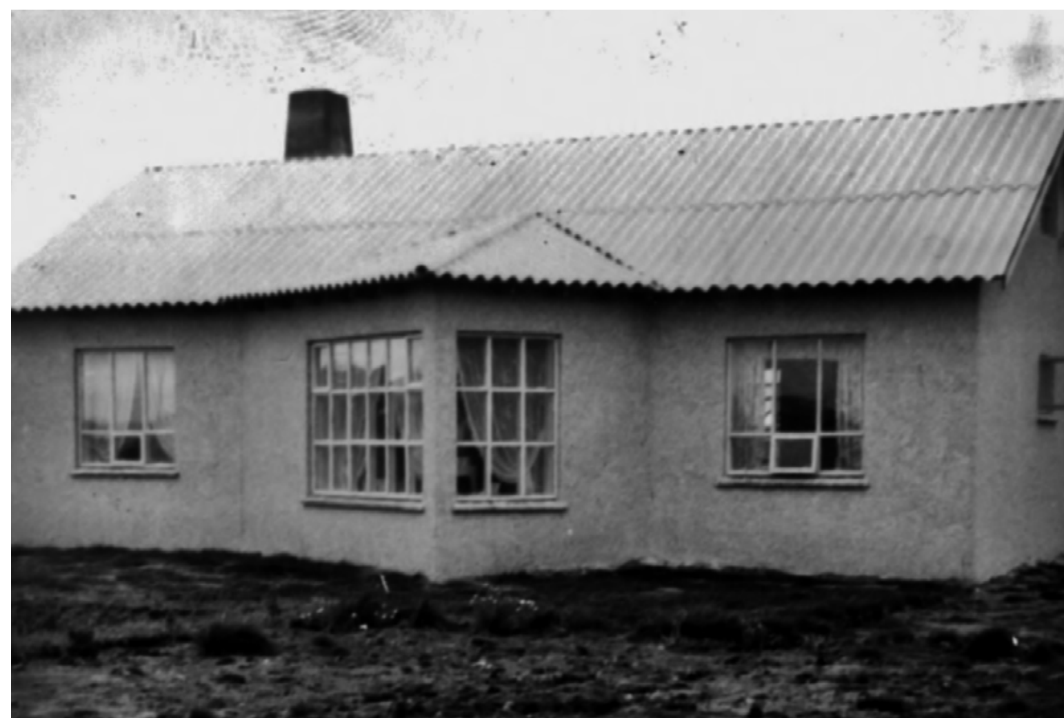
Laufás 10 (Ás). Byggingarár, 1953. Tekið á 6. áratugnum. Steinsteypt hús, útveggir múrsléttáðir. Mænispök. Eig. ljós. Ingunn Svavarsdóttir.
