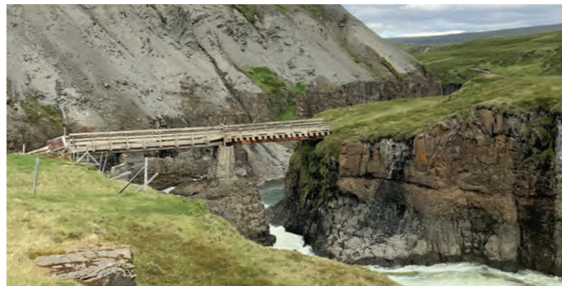
Mynd 2.10 Brú yfir Eyvindará nærri Stuðlagili.
