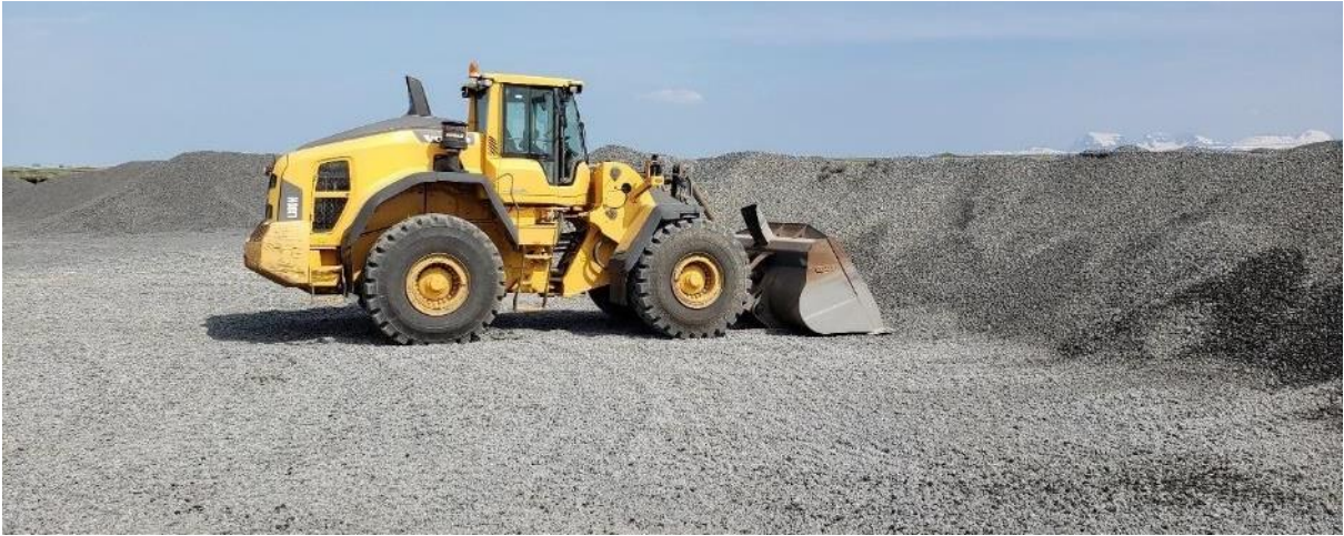
MYND 3.8 Hjólaskófla í Litlabakkanámu.
